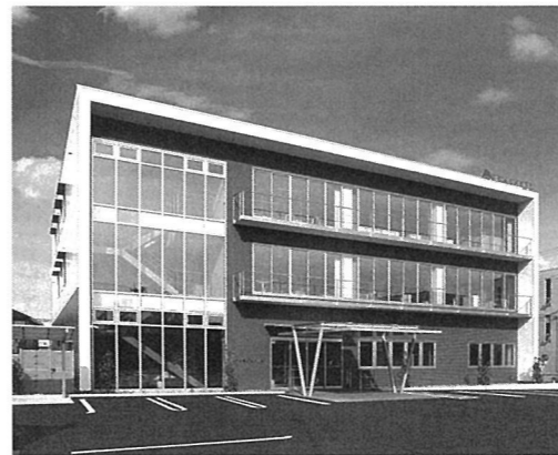
BELS認証を取得した本社ビル
