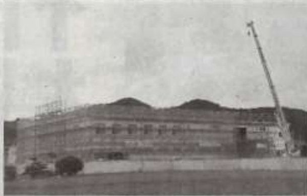
（建設中の新工場）
